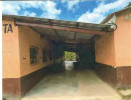
Foto 2: Altura de techo que no corresponde a las medidas de seguridad representando un riesgo
